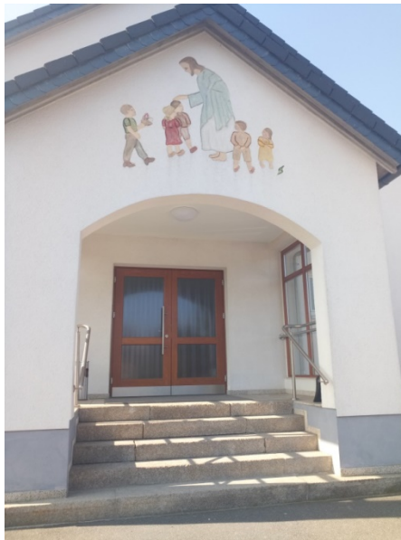
Abbildung 4: Blick auf den Haupteingang des Pfarrsaals
