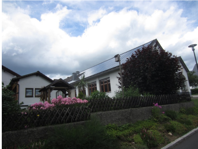
Abbildung 6: Blick auf die Photovoltaikanlage auf dem Pfarrsaal
