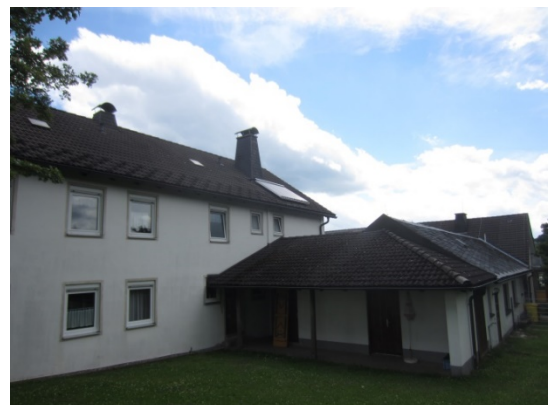
Abbildung 11: 85 m 2 stehen als Jugendzimmer, Garage und Abstellräumen zur Verfügung
